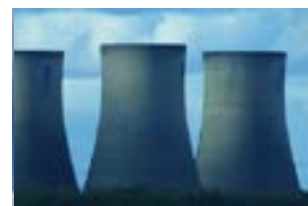
■ Tours de refroidissement
