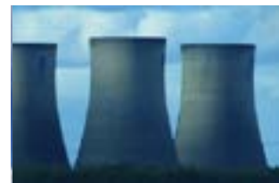
■ Tours de refroidissement
